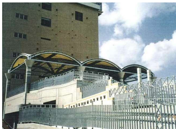
那覇港 泊ふ頭地区人工地盤地下駐車場【沖縄県】
