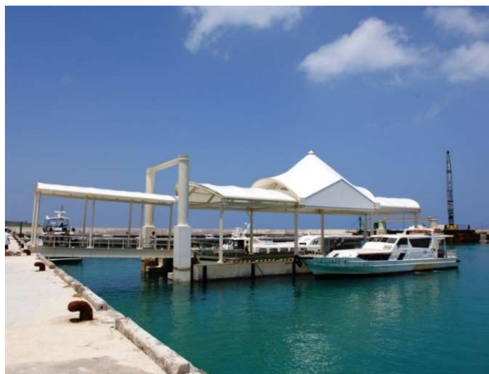
波照間漁港 浮棧橋【沖縄県】
